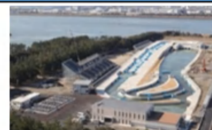
カヌー・スラロームセンター
