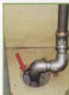
流し台下の排水管まわり
