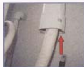
配管にカバーがついている場合 開口部に注意
