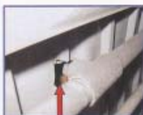
水道管の壁貫通部分
